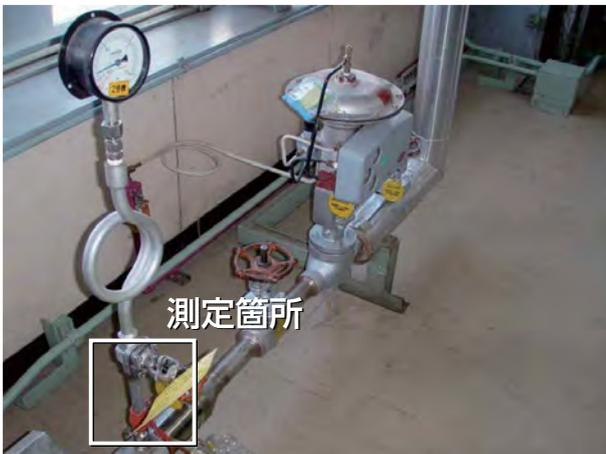
図17 実機配管の測定箇所 (補助蒸気系小口径配管)
