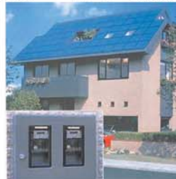
図10 太陽光発電を利用した住宅 太陽光発電をし、電気があまった場合(右のメーター)は電力会社に売り、不足する場合(左のメーター)は買うようになっている。
